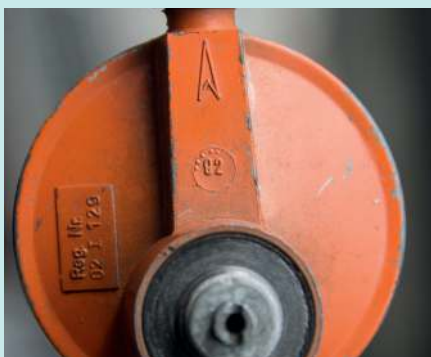
↑ Een veel te oude gasdrukregelaar (1992). Die moet elke tien jaar worden vervangen
